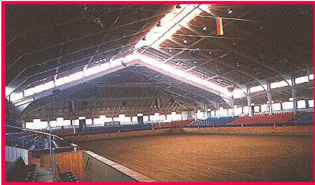
Außen- und Innenansichten der "Graf-von-Lindenau-Halle" des Reit- und Veranstaltungszentrums von Neustadt/Dosse
